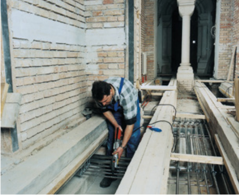
Beim Einbau von modernen Heizungssystemen in denkmalgeschützte Gebäude sind die Vorteile eines kalten Fügeverfahrens, das Brandrisiken ausschaltet, besonders augenfällig. Foto: Geberit, Jona (CH)
